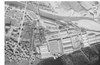
Orthophotographie de l'usine et du village de Chippis, 1938 © swisstopo
