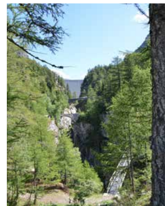
Mauvoisin : pont Venetz, pont routier et barrage E. Reynard
